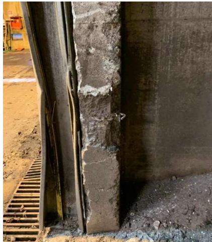
Ferri di armatura in evidenza
