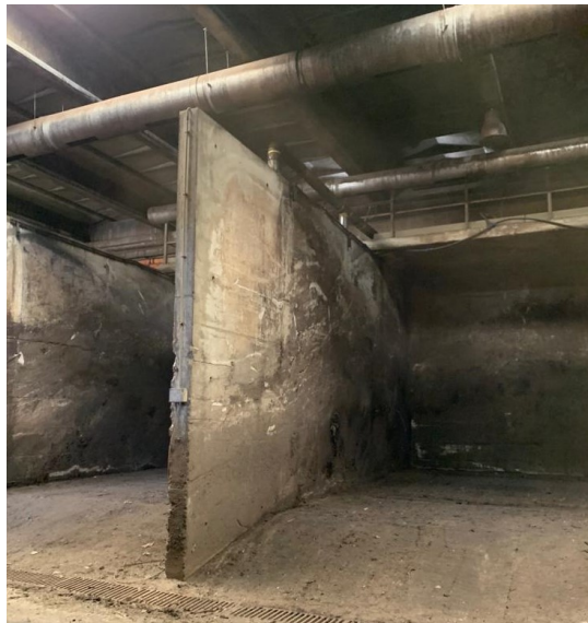
rampe di accesso alle celle
